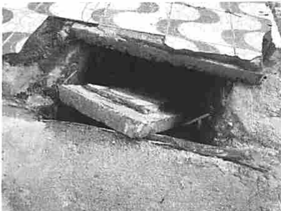
Foto 13 – Rua Rosa Vieira, Bueiro existente.
