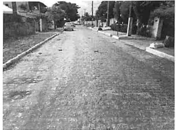
Foto 30 - Rua Antônio Alves trecho inicial.
