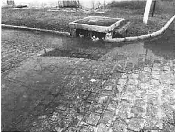
Foto 5 – Drenagem existente, na Rua Antônio Alves, trecho intermediário.
