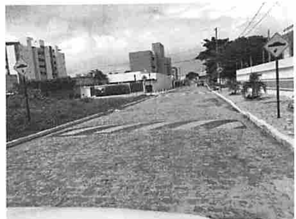
Foto 24 - Rua Maria de Lima Mimosa, trecho intermediário.
