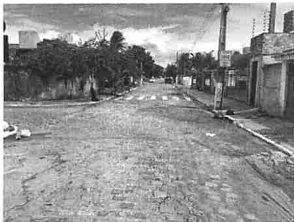
Foto 17 – Rua Rosa Vieira, trecho Final.
