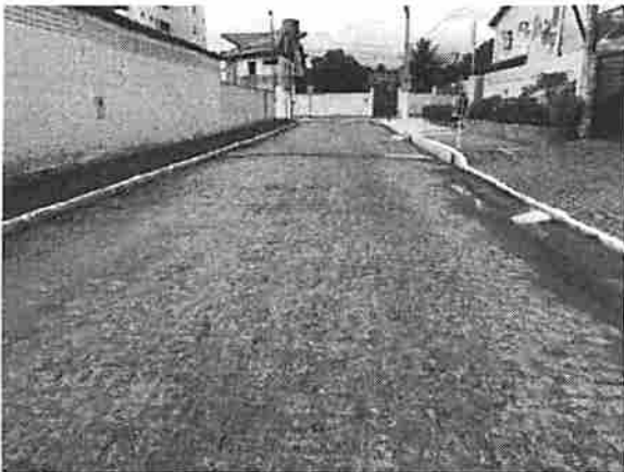
Foto 7 – Rua Antônio Alves, trecho Final.
