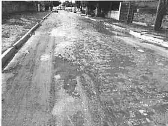
Foto 29 - Rua Antônio Alves trecho inicial.
