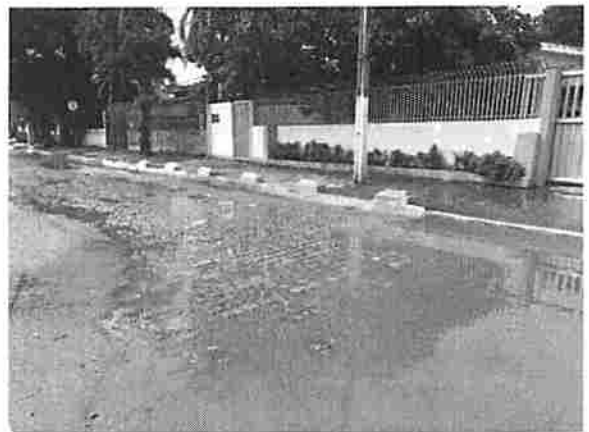
Foto 28 - Rua Antônio Alves trecho inicial.
