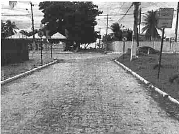
Foto 32 - Rua Antônio Alves trecho final.
